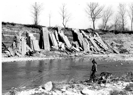
Foto 2 – Marzo 1978 Curva dell'Arctica – Sponda sinistra Solette in laterizi armati scaricate sulla scarpata come difesa spondale!!!
