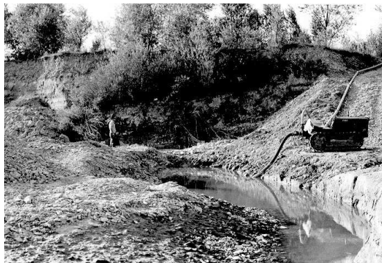
Foto 3 – Fine anni '70 Curva dell'Arctica – in alveo Attingimento di acqua per irrigazione previo scavo di una buca nel greto e costruzione di un accesso con taglio della scarpata
